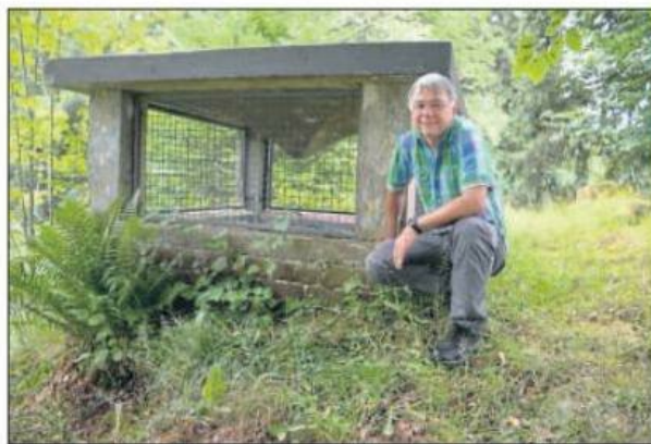
Auf dem Museum-Bunker: Das viereckige Türmchen ist ein Schornstein und eine „ausgeklügelte aerodynamische Tarnung“, hat Bernhard Bock herausgefunden.
