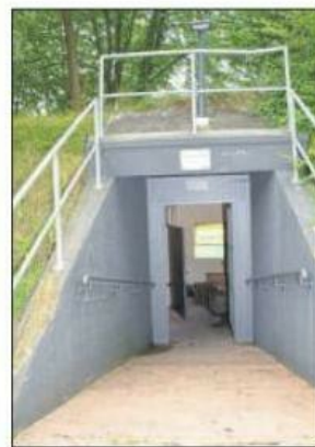
Vor dem Bunker: Der Eingang führt hinein in den Hügel, in dem der Bunker versteckt ist.
