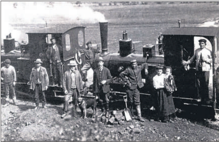
Bauarbeiten im Jahr 1913: Beim Bau der Wohratalbahn entstand dieses Foto mit zwei Feldbahnlokomotiven, Bauarbeitern und Aufsehern bei Kirchhain. Foto: Repro Völker
