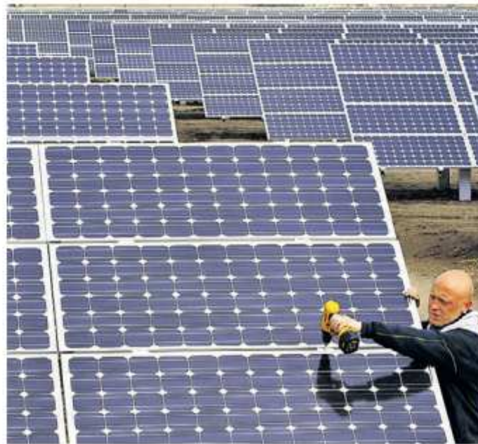
Energie aus Sonnenstrom für die Region: Das ist das Ziel der Bürgerenergiegenossenschaft Ederbergland. Doch für die Umsetzung fehlt noch ein starker Partner.
