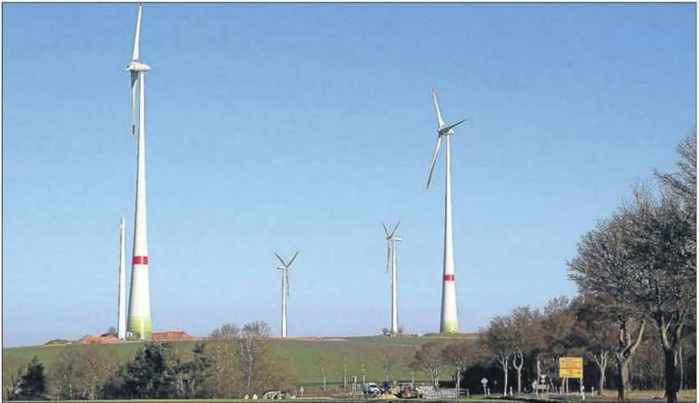
Höher hinaus: Zum Ausbau der Erneuerbaren Energien gehört auch die Windkraft. Neue Anlagen können dabei deutlich größer als ihre Vorgängermodelle sein. Das wird an diesem Beispiel am Ortsrand von Waldeck-Sachsenhausen deutlich, wo noch Reste von älteren Anlagen neben den neu gebauten Windrädern stehen (im Bild links zu sehen). Foto: Müller
