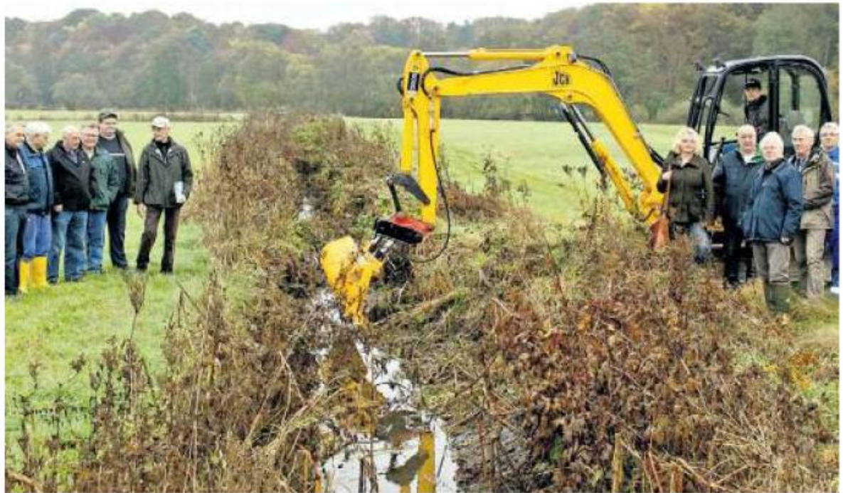
Am Bagger (vorne links) Anna Maria Pohl von der oberen Naturschutzbehörde und Vertretern der Gemeinde und NABU. Auf der linken Grabenseite NABU-Projektbetreuer Günter Faust (rechts) mit den Vertretern des Wasser- und Bodenverbandes und dem Ersten Beigeordneten der Gemeinde Allendorf, Kurt Kramer.
