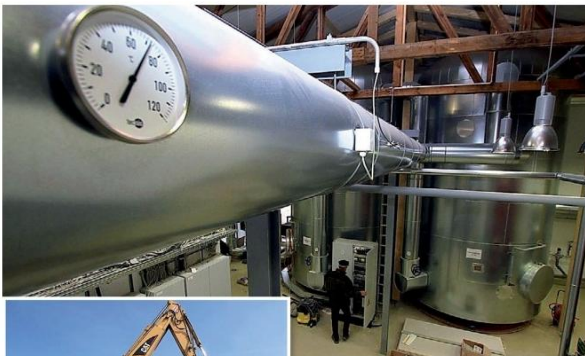
Ein Blick in das Innenleben der Energiezentrale der Genossenschaft Nahwärme Schönstadt. Links: In nur sechs Monaten Bauzeit wurden 2012 die 13 Kilometer Leitungen verlegt.
