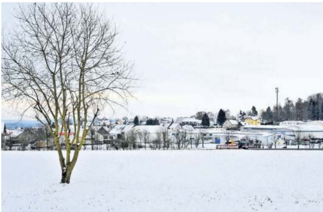
Zwischen der Motocross-Strecke und der Bundesstraße 253 bei Laisa soll ein Solarpark entstehen, der rein rechnerisch 260 Haushalte mit Strom versorgen könnte. Er soll im Sommer 2013 ans Netz gehen. Foto: Mark Adel
