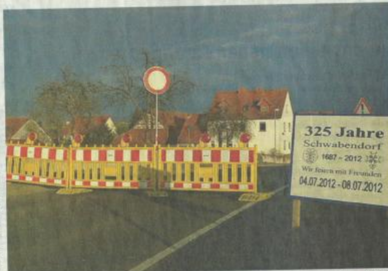
Die Straßenbauarbeiten in Schwabendorf sollen so gestaltet werden, dass die Festwoche möglichst nicht beeinträchtigt wird. Foto: Matthias Mayer
