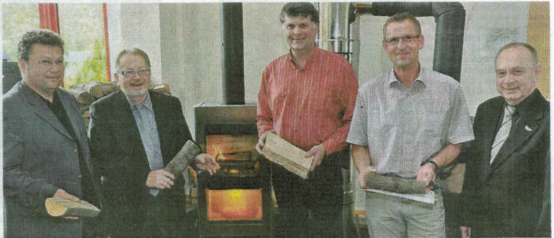
Umweltfreundliche Wärme aus Holz: Bodo Specht, Peter Goebel von der Firma PG-Technologie, Stefan Schulte und Kai-Uwe Spanka von der Region Burgwald-Ederbergland und Wirtschaftsförderer Siegfried Franke stellten das geplante Wärmetausch-System vor. Es wird derzeit entwickelt und soll ab Herbst 2011 für die „Xeos“-Kamine erhältlich sein. Foto: Mark Adel
